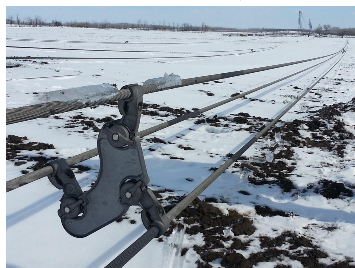
2. ábra: A Munkács-Sajószöged 400 kV-os vonalon a távvezeték sodronyira fagyott, több centiméter vastag jég
