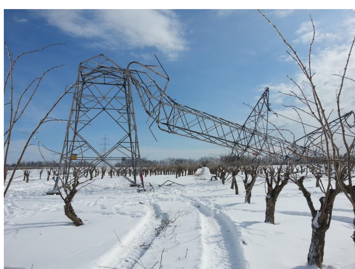
1. ábra: A Kisvárdasajószöged és Munkács-Tiszalök 220 kV-os távvezeték vonalán kidőlt egyik oszlop
