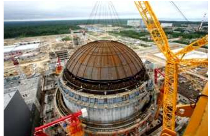
A Leningrád-II építése
