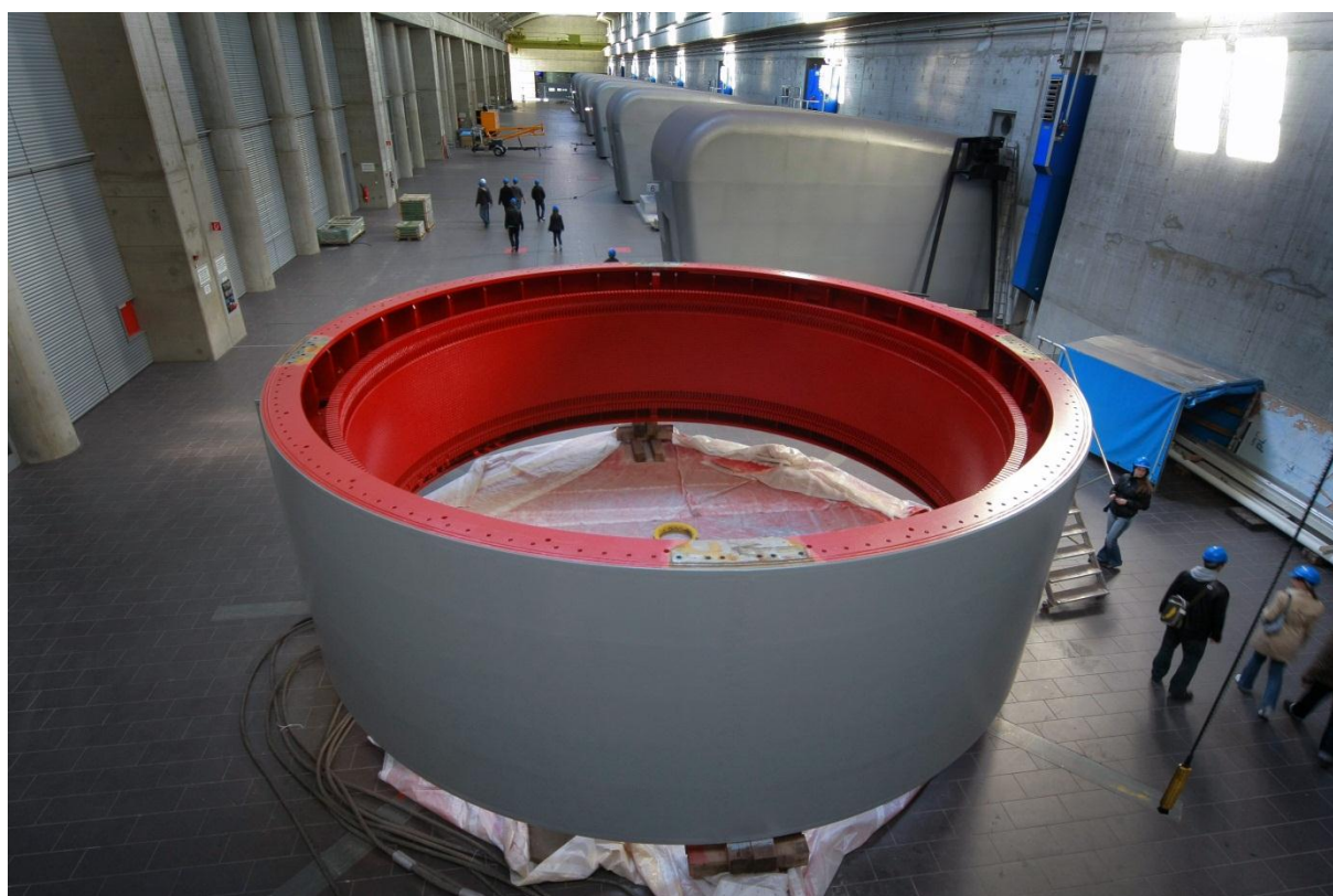
8. ábra: Szinkrongenerátor állórésze
