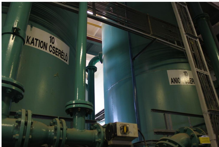
5. ábra: A sótalánító anion és kation cserélő tartályok
