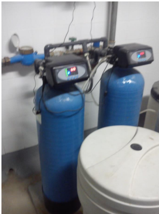
1. ábra A hőközpont vízlágyító rendszere
