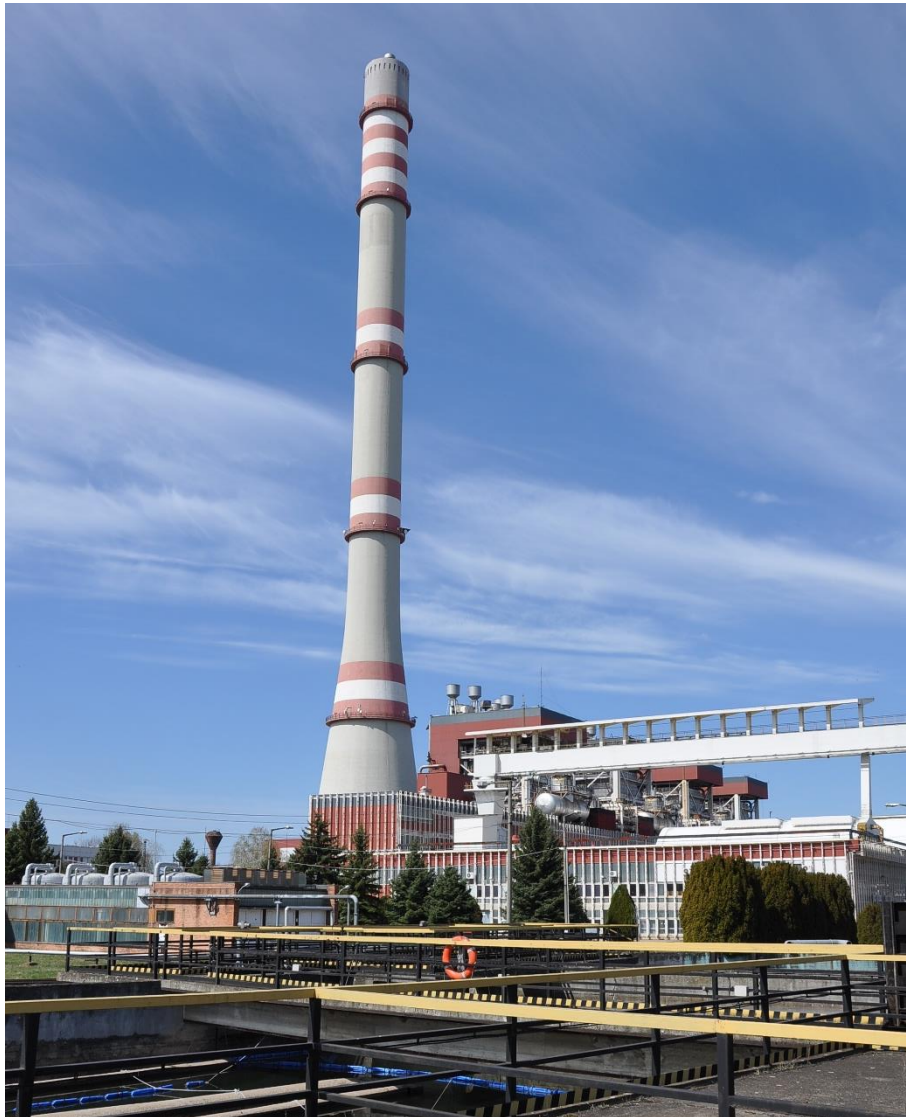
1. ábra. Az erőmű a vízkivételi mű felől nézve
