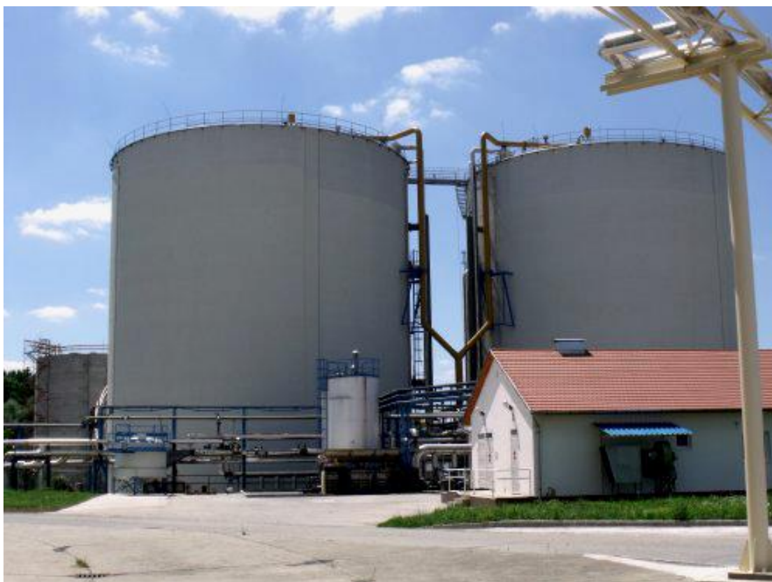
1. ábra: A két fermentor, háttérben az épülő utófermentorral
