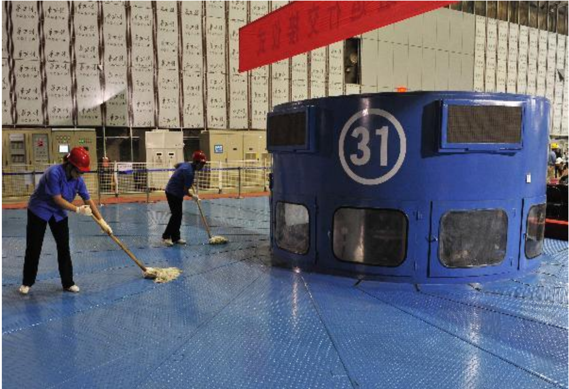
A 31. számú (az utolsó előtti) 700 MW-os hidrogenerátor
