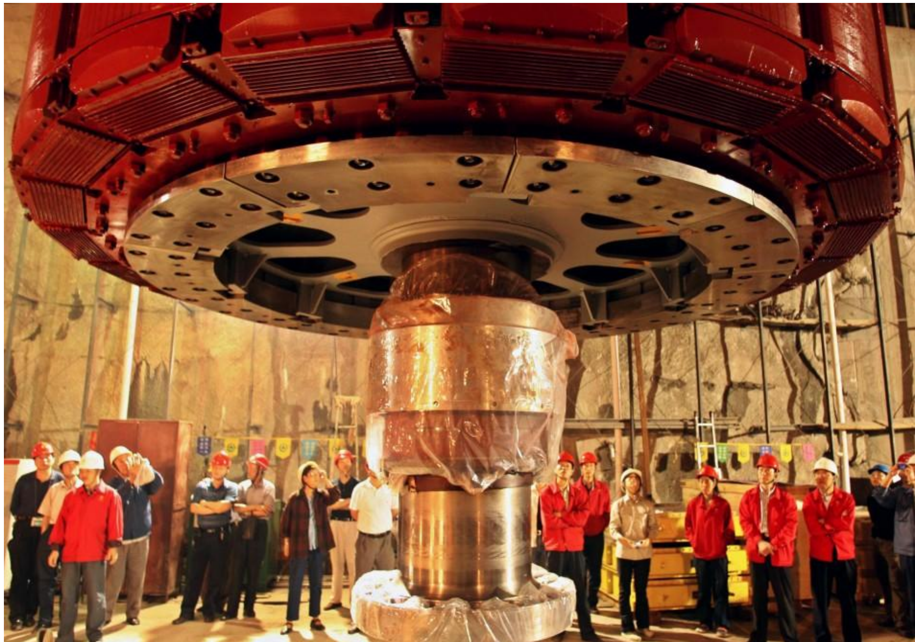
A 840 MVA-es generátor forgórésze az állórészbe való beemelés előtt
