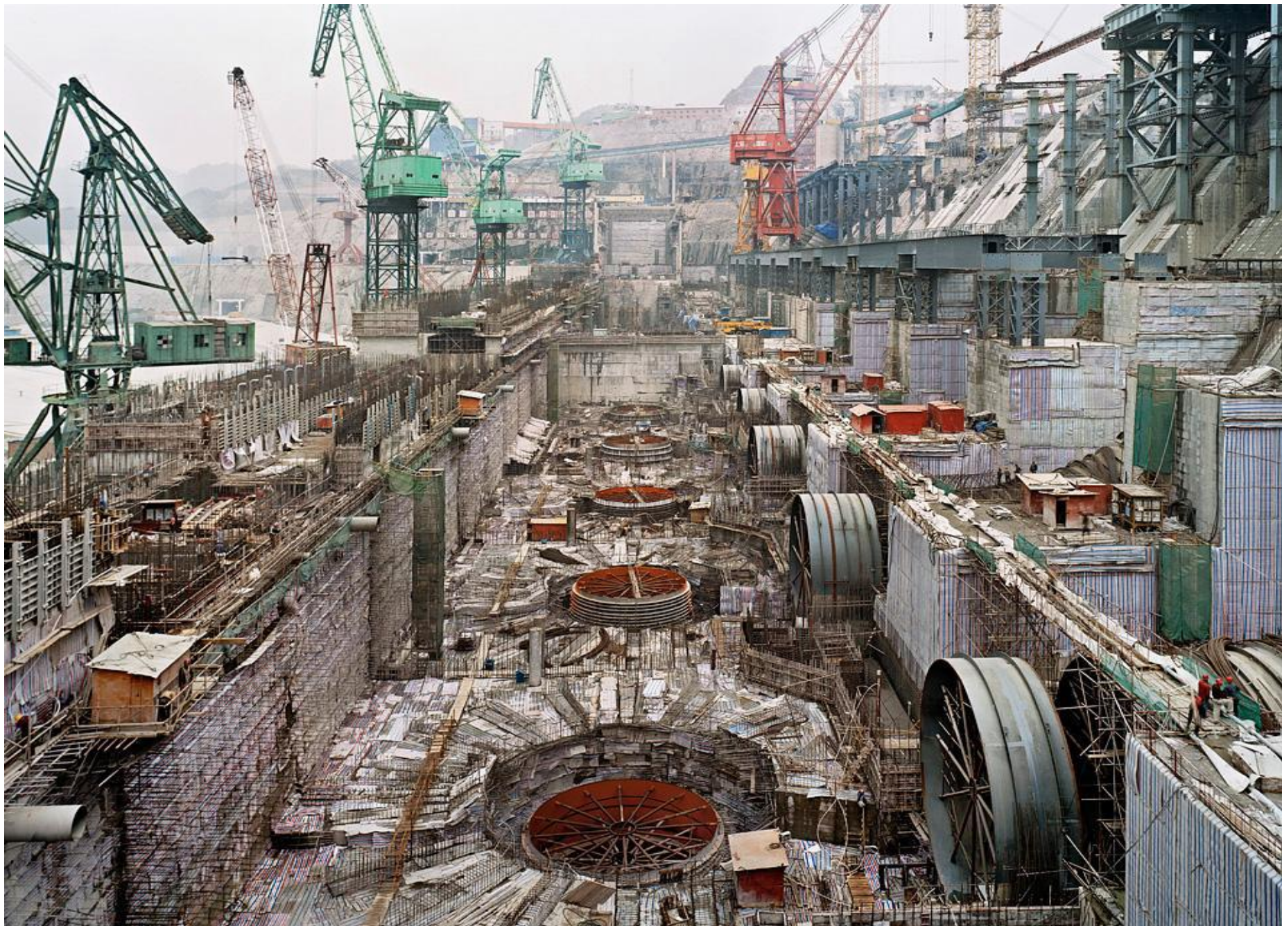
A turbinaházak szerelése a jobbparti gépcsarnokban
