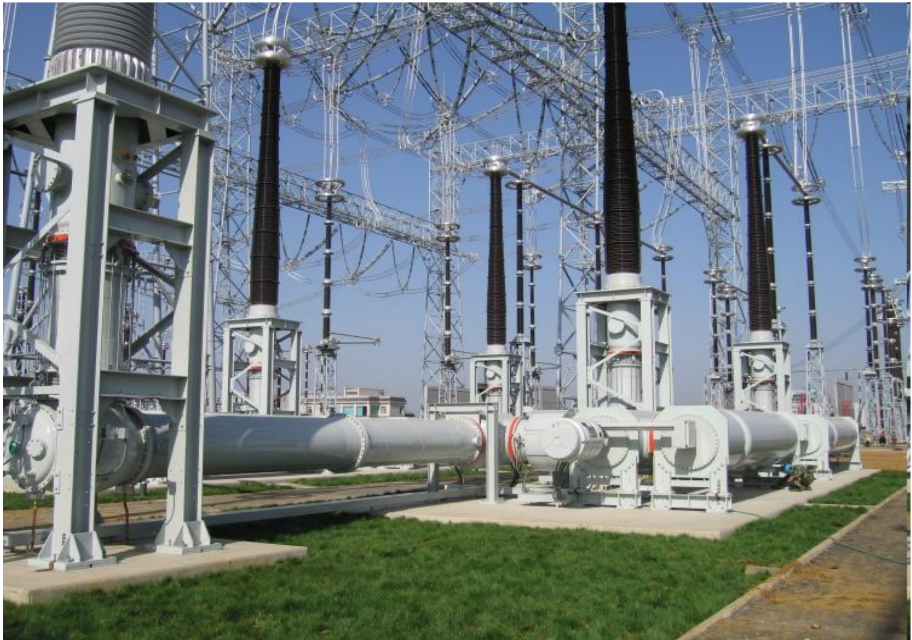
Az 1100 kV-os SF 6 gázszigetelésű megszakító
