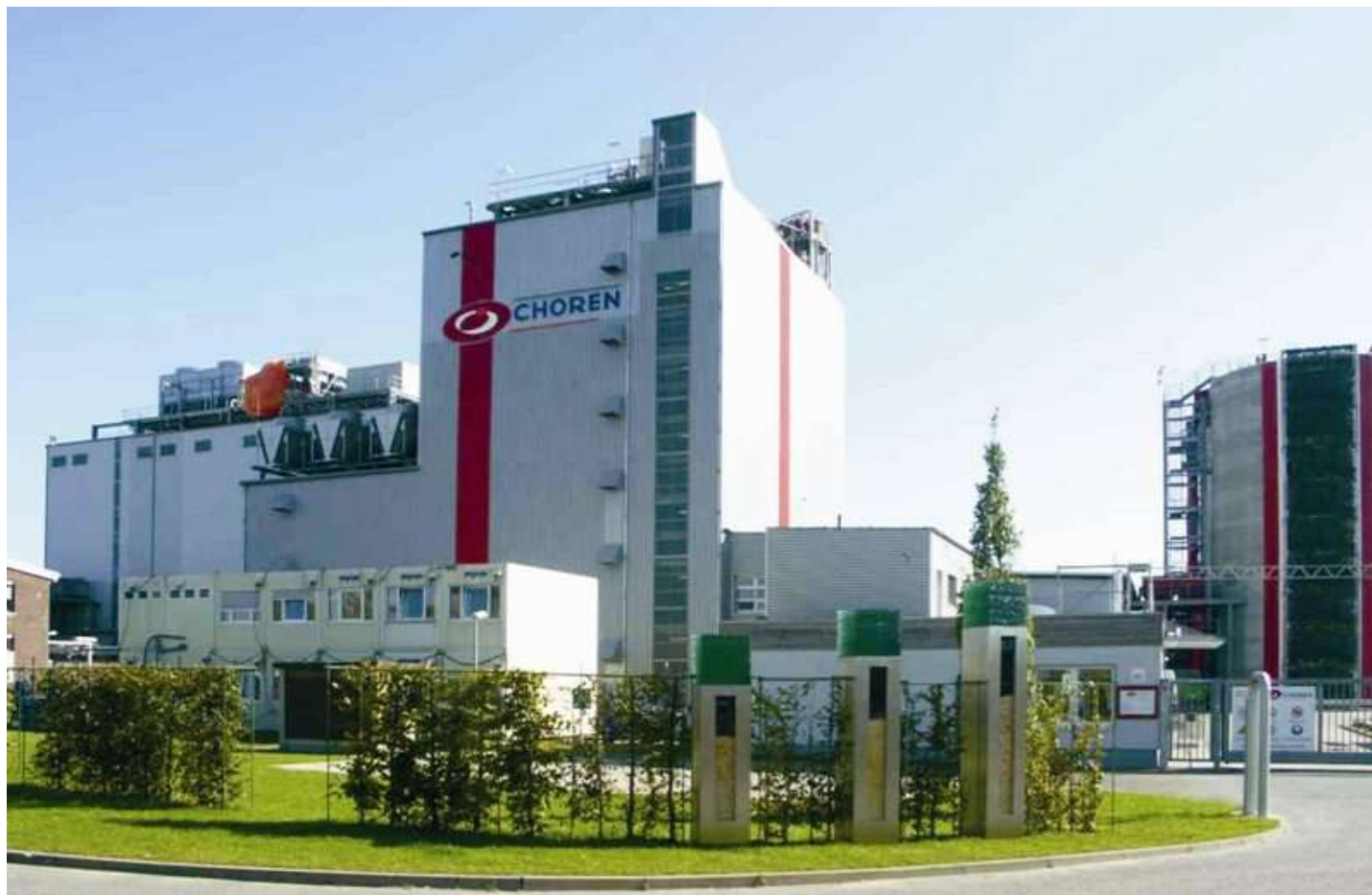
A Choren Industries GmbH freibergi üzemanyaggyártó üzeme (Beta Plant)
