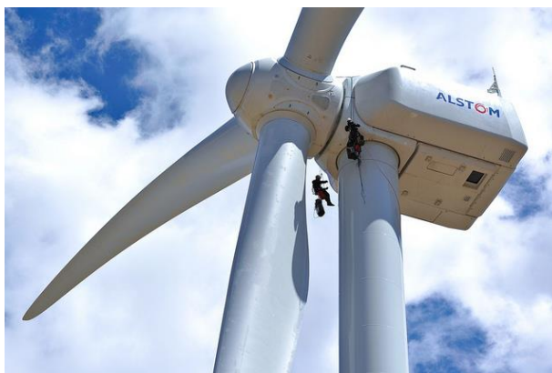
10. ábra: Az Alstom ECO 122 típusú szélturbínája
