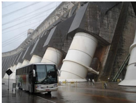
6. ábra: 500 kV-os kivezetések sodronyai
