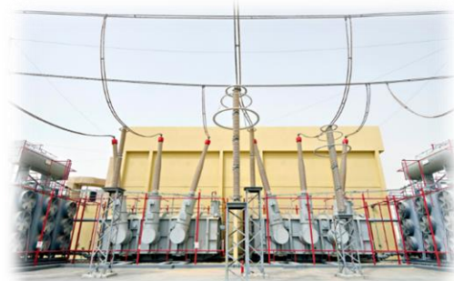
7. ábra: "c" kapcsolás szerinti transzformátor
