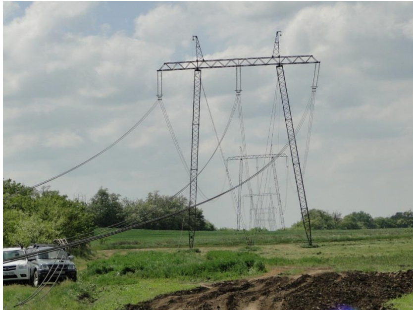
3. kép Újjáépített kikötött portál típusú tartóoszlop a Munkács-Sajószöged 400 kV-os távvezetéken
