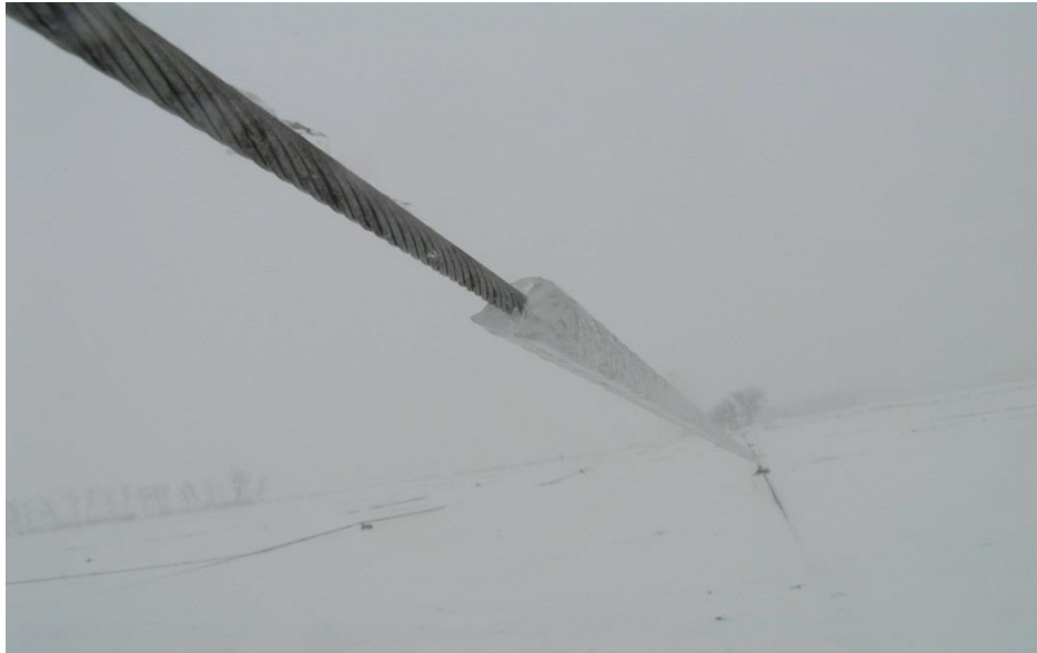
2. kép A sodronyokra rakódott rendkívül vastag jégréteg
