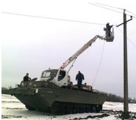
5. kép Szigetelőcsere az elosztó hálózaton a Honvédség lánctalpas járművének segítségével
