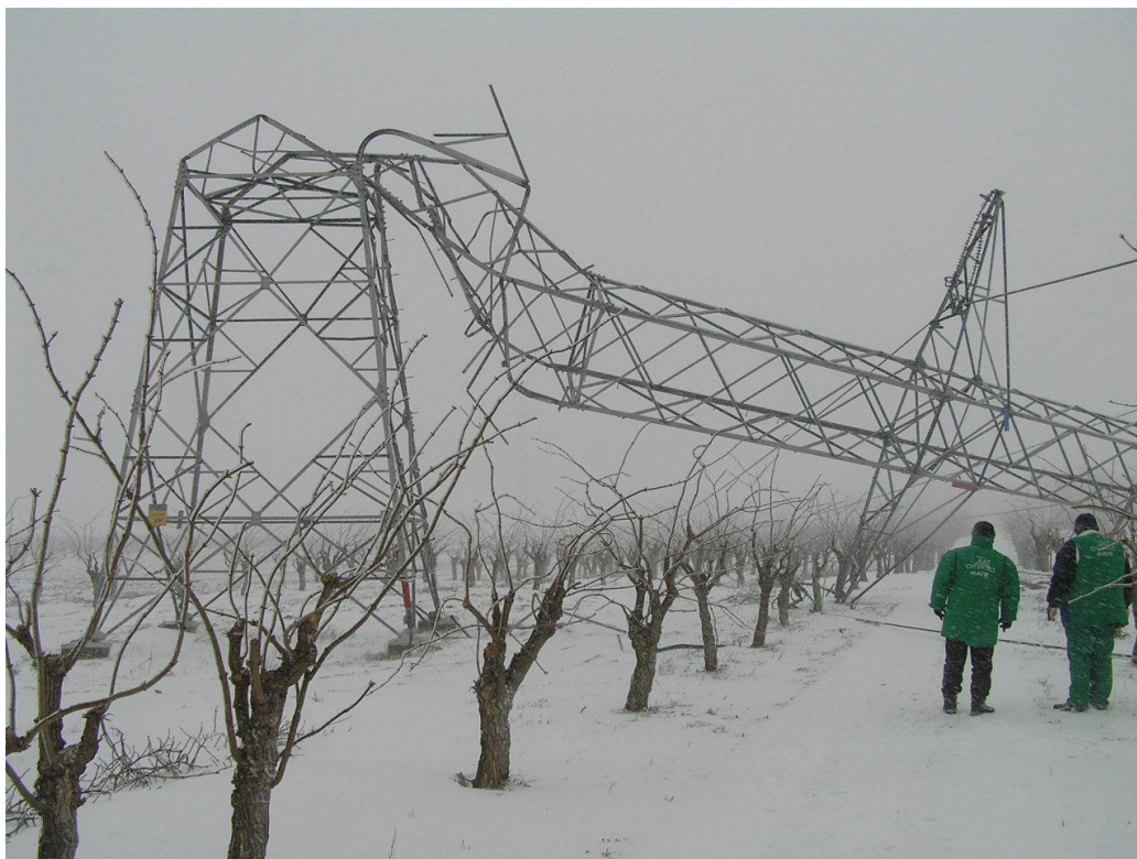
1. kép A Kisvárdasajószöged és Munkács-Tiszalök 220 kV-os, kétrendszerű távvezetékén kidőlt Soroksár típusú tartóoszlop
